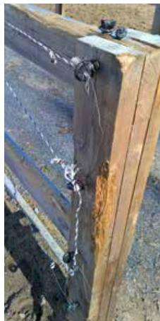
Однако, если проводник изгороди необходимо временно связать из-за отсутствия соединителей, прохождение электрического тока можно облегчить, открыв металлические провода проводника на небольшом участке узла и плотно соединив их друг с другом.
